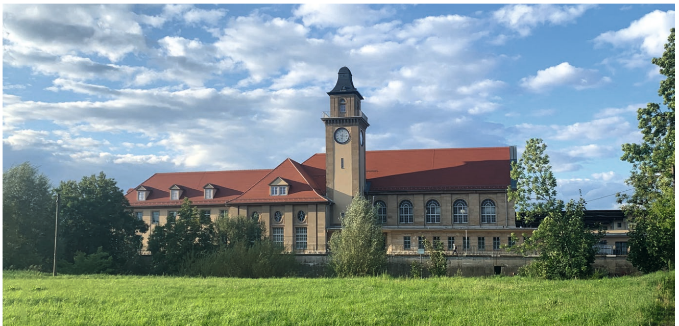
Abb. 30: Bahnhofsgebäude Zeitz, Haltepunkt der geplanten S-Bahn Leipzig-Zeitz-Gera (Foto: Projektbüro)
