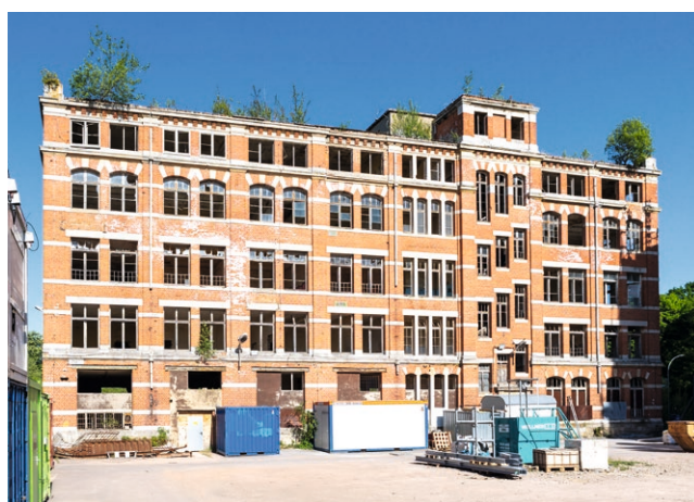
Abb. 4: Das ehemalige ZEKIWA Verwaltungsgebäude ist Bestandteil des NEB Reallabors ZEKIWA Zeitz (Foto: Medienkunst Weimer)
